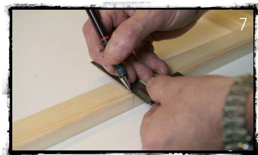
Obr. 7 • Použijte pravouhlý úhelník a tužku k naměření středů na každém ramenu rámu.
